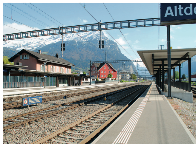
Der Bahnhof Altdorf im heutigen Zustand Foto: Buchner Bründler
